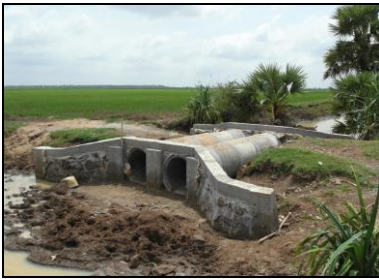
Vannes-écluses à Chamlak
